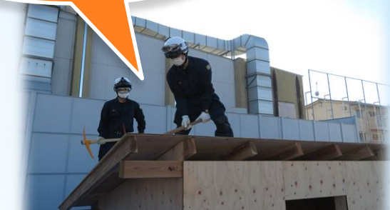
つるはしで屋根を破壊し、室内の様子を確認
