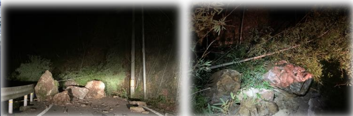
檮原町 崖崩れ
